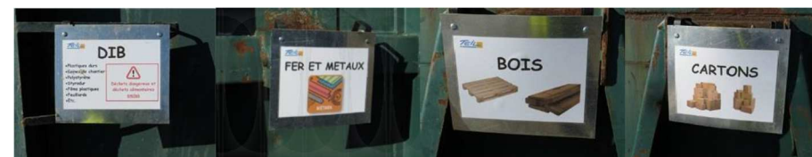
Affichages sur des bennes de tri sélectif (Source : Abies, suivi de chantier de centrale photovoltaïque)
