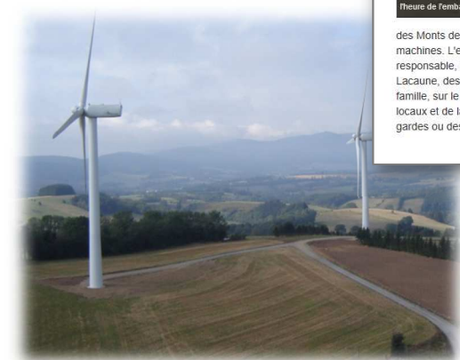
Exemple de remodelage d'une plateforme du parc éolien de Barre (VALECO)
